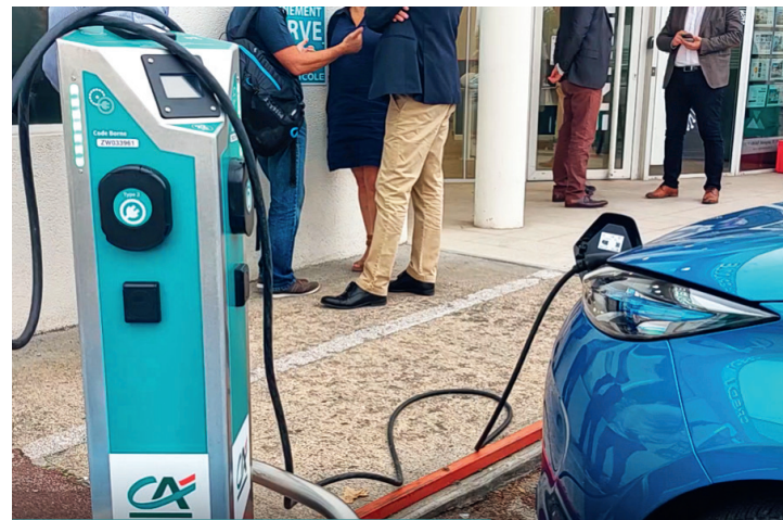
Exemple d'une borne électrique installée sur son territoire par le Crédit Agricole du Nord Est
